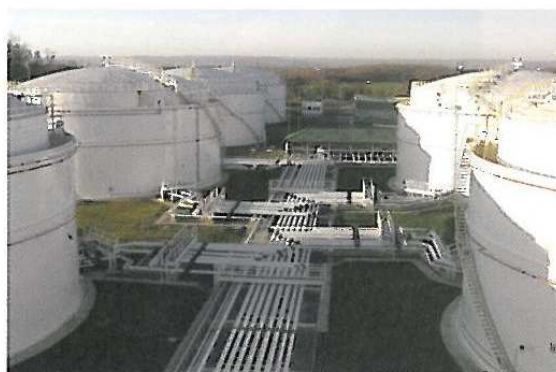
Jako dodávka „na klíč“ byl v roce 2006 dokončen nejmodernější sklad pohonných hmot v ČR v Sedlnicích poblíž Ostravy..., On a „turn-key“ basis was in 2006 finished most modern fuel storage in Czech republic in Sedlnice near Ostrava...
